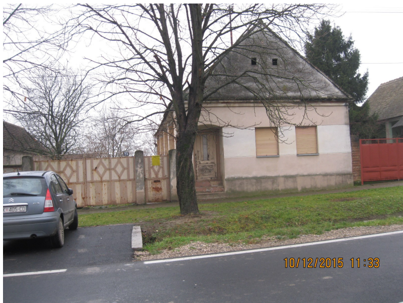
Lijevo: Fotografija pročelja kuće. Stanje 9.12.2015.
