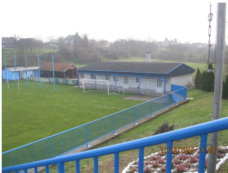
Lijevo: Fotografija pročelja svlačionice i pomoćnih zgrada na nogometnom igralištu. Stanje 11.12.2015.
