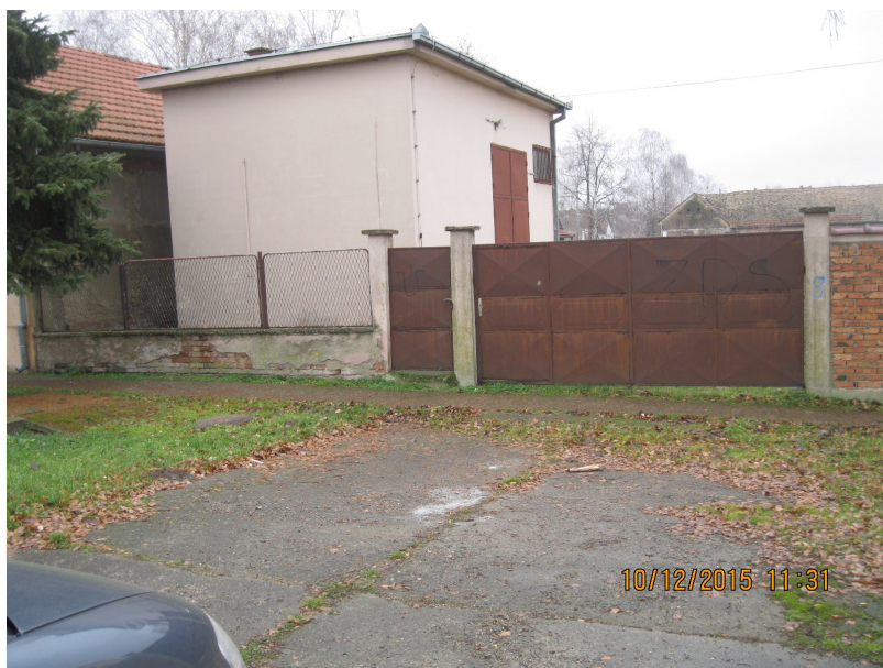
Lijevo: Fotografija crpne stanice s ulice. Stanje 9.12.2015.
