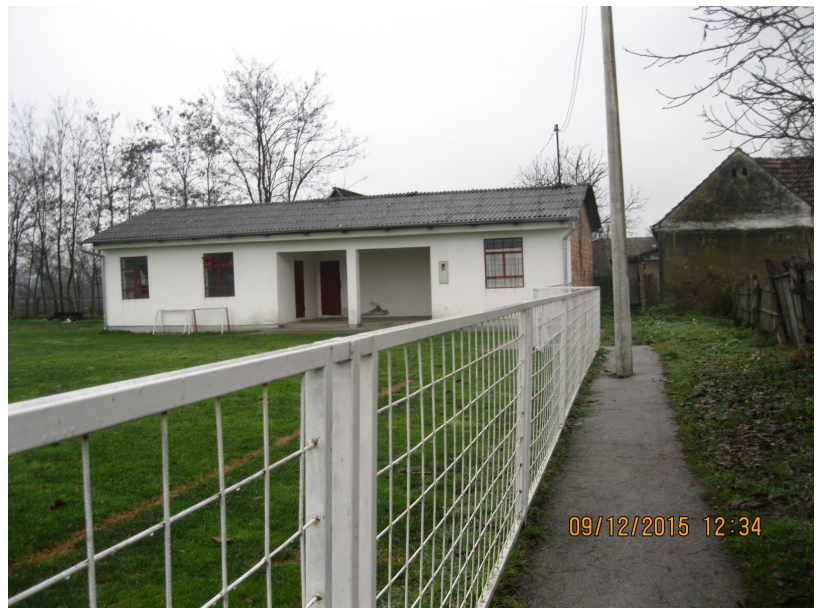
Desno: Fotografija sjeveroistočnog pročelja zgrade, slikana s prilazne staze. Stanje 9.12.2015.
