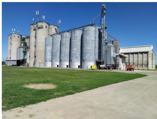
SLIKA 5: SILOS PZ JANKOVCI
